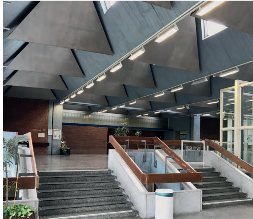
Treppenhaus des Hörsaalgebäudes (reale Situation)
